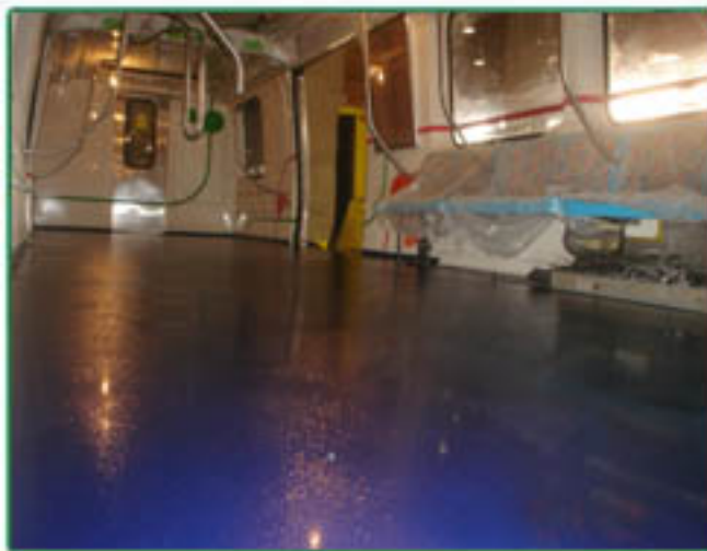
Obra de Revestimento de piso dentro dos vagões de passageiros CPTM.
